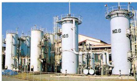
コークス炉ガス用乾式脱硫装置
