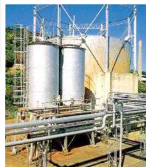
消化ガス用乾式脱硫装置
